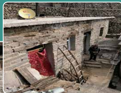
房子修繕一新，可再為曹伯伯遮風擋雨
